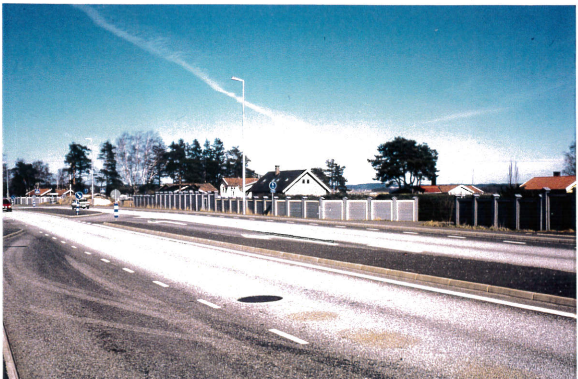
Bulleråtgärder på ombyggd sträcka genom Forsbäck.
