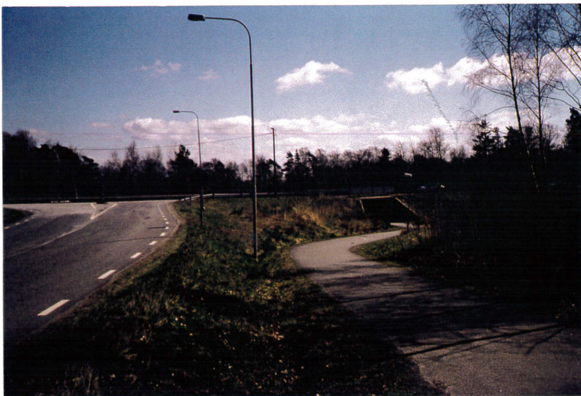
Gång- och cykelport vid korsningen Skällaredsvägen och nuvarande väg 940.
