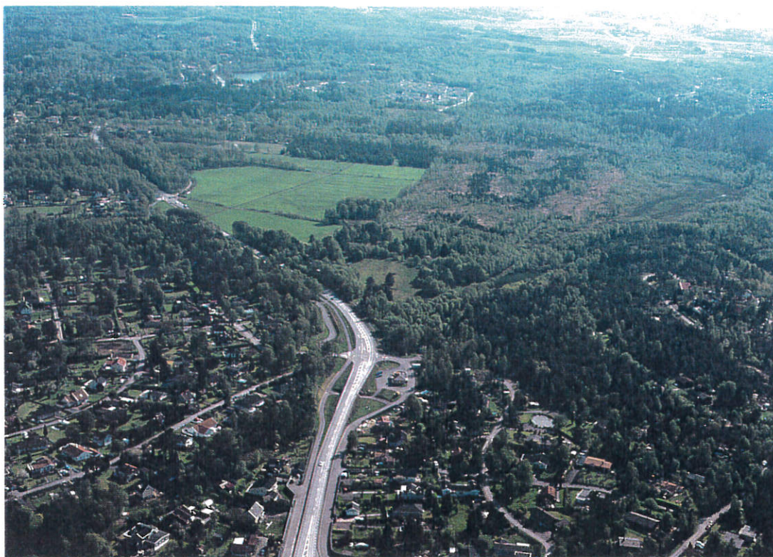
Vy över slutet på den nybyggda delen vid Forsbäck mot söder.
